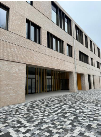
HI_GS_Nebau_Bochum.jpg: Hochmodern, nachhaltig und zukunftsgerecht: die Grundschule an der Feldsieper Straße in Bochum Hamme.
